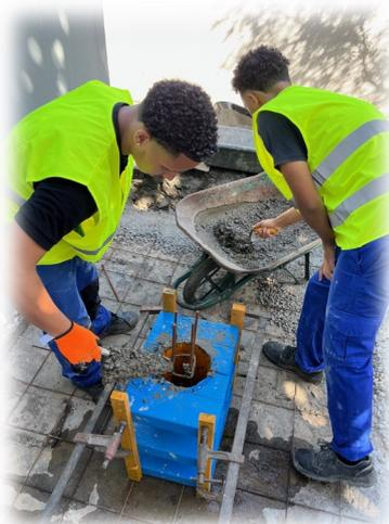
Ils ont ensuite coulé le béton dans le fond du bassin en le répartissant uniformément et en utilisant la truelle et la taloche pour obtenir une surface plane et régulière.
