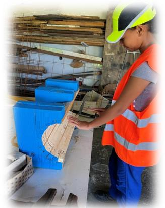
Ils ont soigneusement mesuré et tracé les dimensions et ont assemblé les liteaux avec des clous et des vis pour former un cercle parfait.
