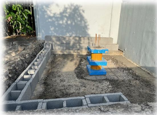
Après le bétonnage du fond du bassin, les élèves ont procédé à l'exercice de calcul et de mise en place des blocs de parpaing US pour les murs. Cette étape est essentielle pour garantir la stabilité et la solidité de l'ouvrage. Ils ont donc commencé par réaliser un calepinage, c'est-à-dire une disposition préalable des blocs en fonction de leur taille et de leur forme, afin de déterminer la quantité nécessaire et leur positionnement précis.
